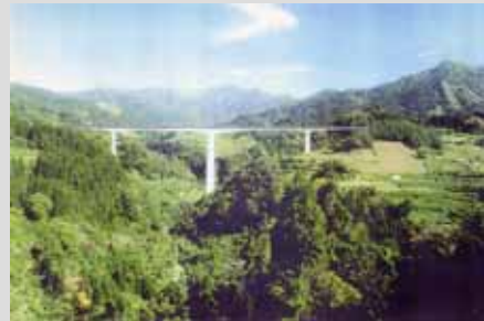
「上岩戸大橋(仮称)」の完成予想図。完成すると橋の長さ410m、橋脚の長さ111m、高さ122mと林道橋としては日本一の規模となります。
