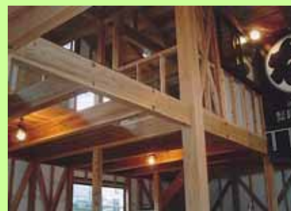
高千穂スギの風合いを活かした家づくり。柱を隠さず、見せる工法で造っています。
