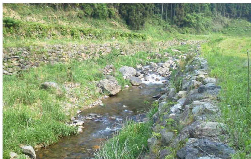
切天端の施工例(竣工後) ⇒植生により天端のラインがぼかされて、柔らかい印象となる
