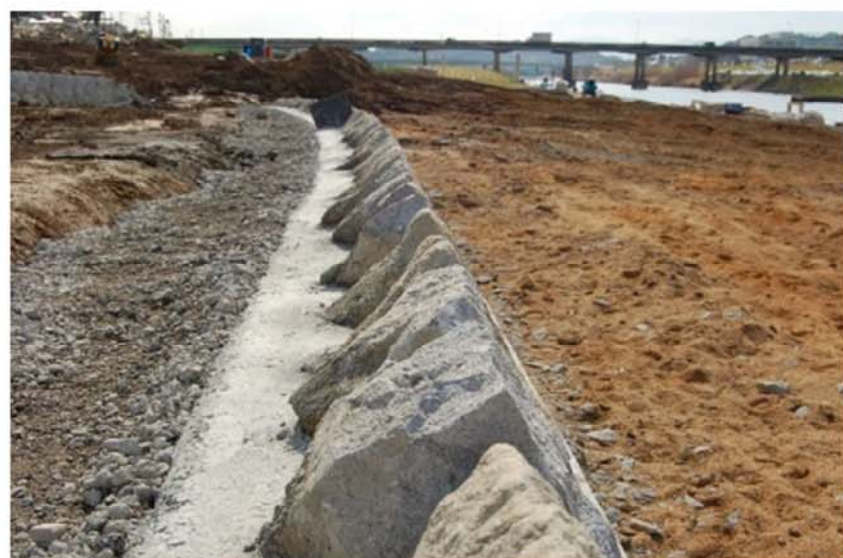
切天端の施工例(覆土前)
