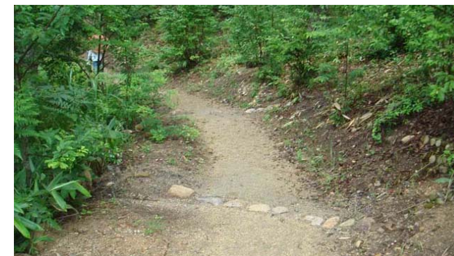
【土系舗装】あづみの公園（長野県）
