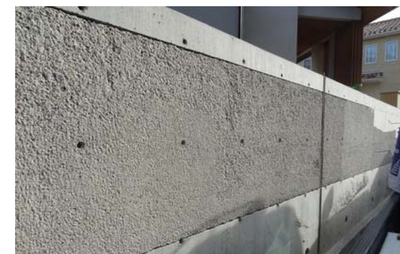
コンクリート壁の“はつり”
