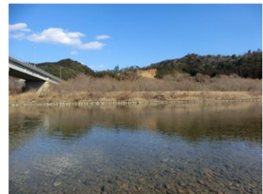
図4 St.3 的野大橋
