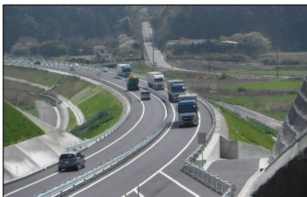
地域高規格道路の整備 （都城志布志道路：都城市）
