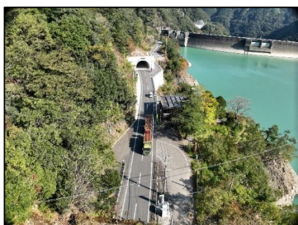
命の道となる中山間地域での道路整備 （国道219号：西米良村）
