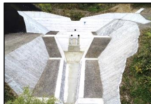
整備された砂防施設
