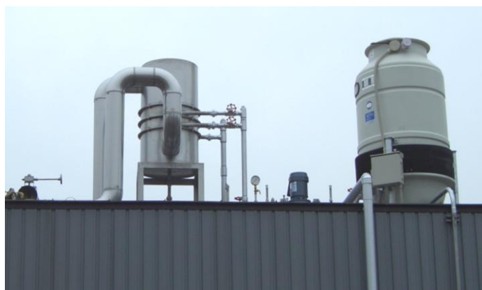
乾燥機の排出蒸気と凝縮液（精油）及び冷却装置
