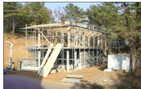
2 方向ラーメン施工試験
