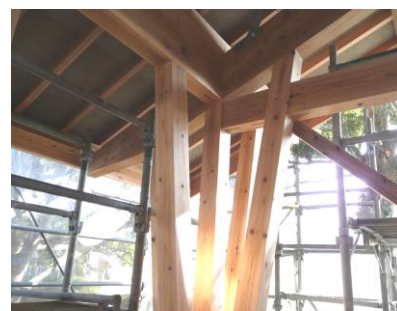
ゲストハウスの軸組み
