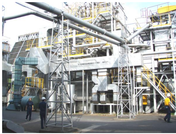
燃焼灰と木質燃焼プラント
