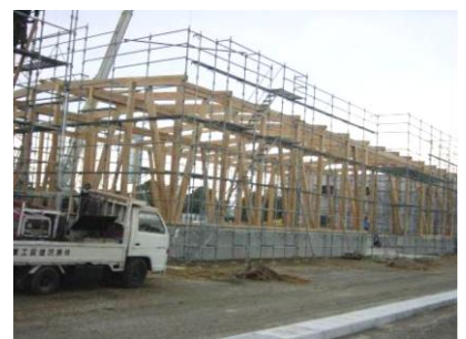
工場の軸組み
