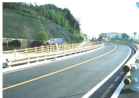
木製ガードレール
