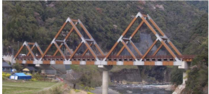
写真1 かりこぼうず大橋の外観
