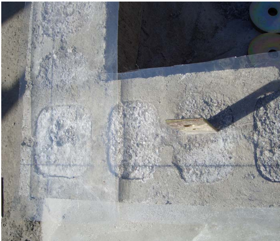
図3 フィルムバリアーを施工した基礎
