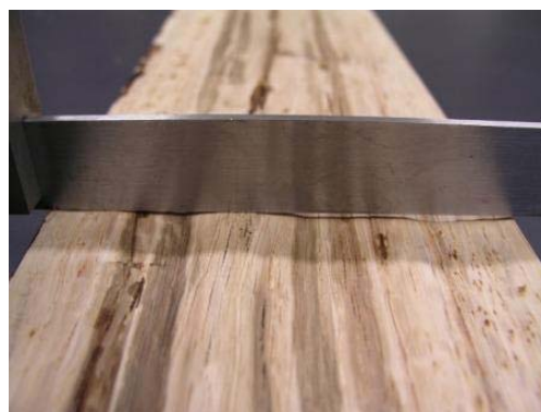
図2 試験体木裏面の落ち込み
