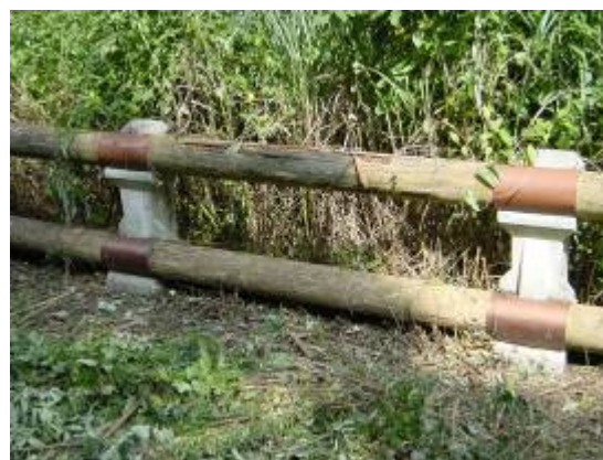
写真9 林道沿いの施工地
