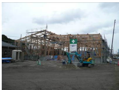
写真3 建て方の状況
