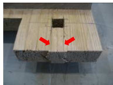
図2 ほぞの込栓打ちこみ部からのせん断破壊
