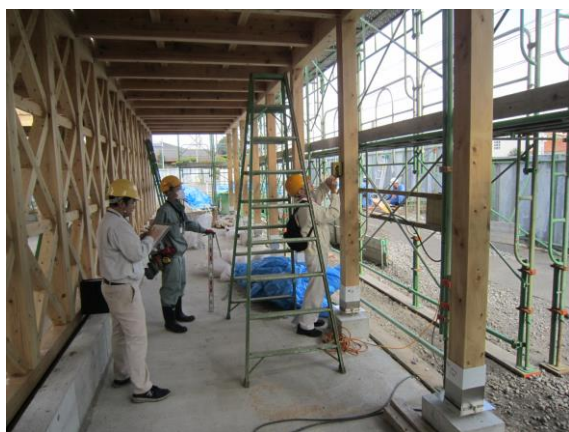
（小林市新庁舎建設工事）
