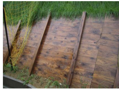
写真-2 法面パネルの試作品 (施工後10箇月経過時)
