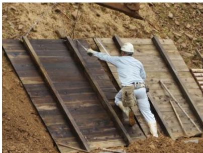
写真-1 法面パネルの試作品(施工中)
