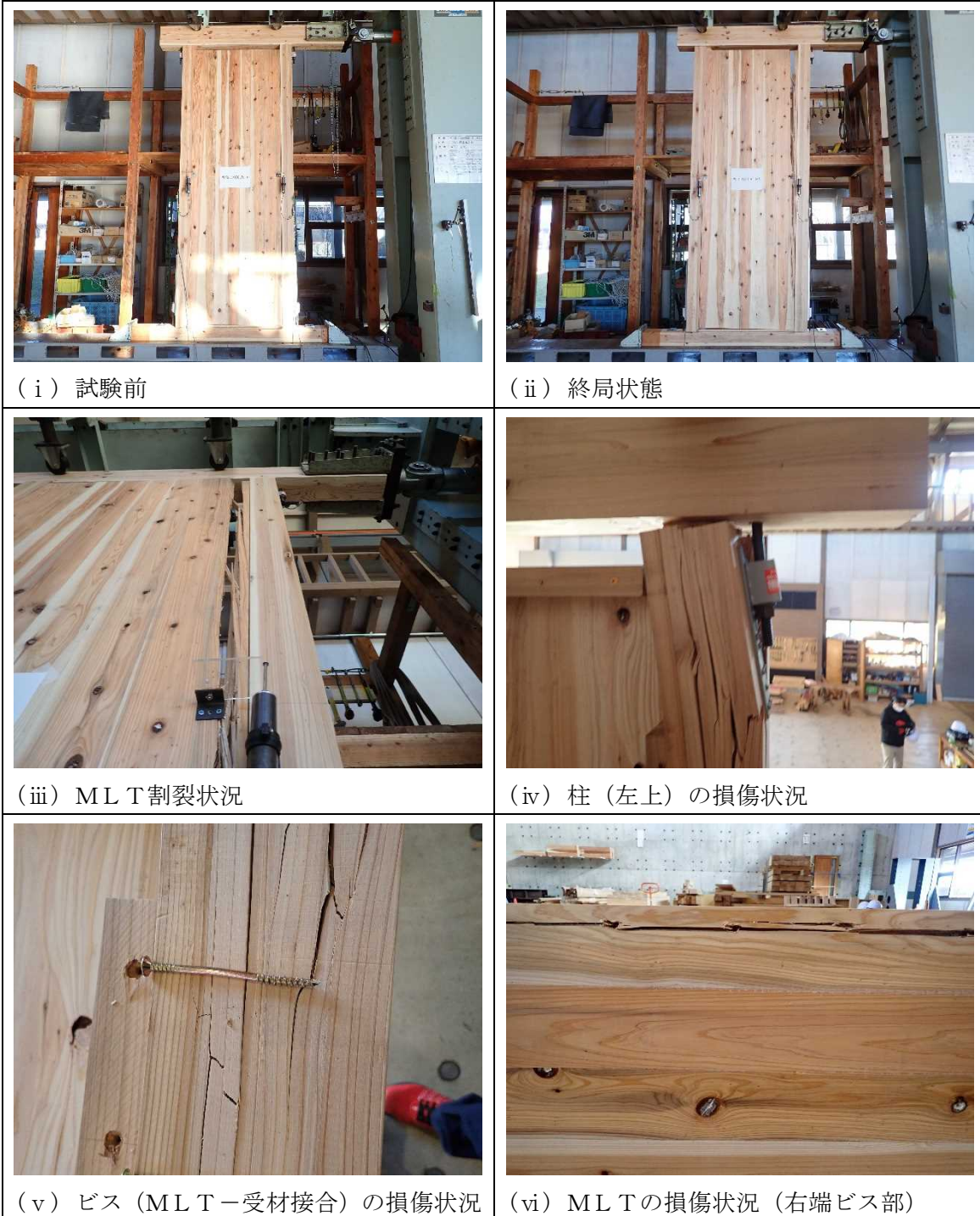
写真1 出隅対応型－1 試験体の破壊性状
