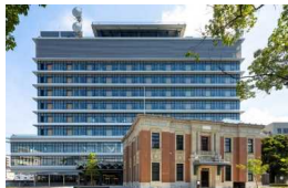
宮崎県防災庁舎 (宮崎県HPより)
