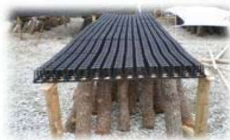
写真－1. フラワートレイ敷設状況
