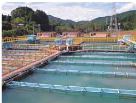
④沈澱池 にがりがたくさんあるときは、薬品を使って、にがりをとりのぞいていくんだ。
