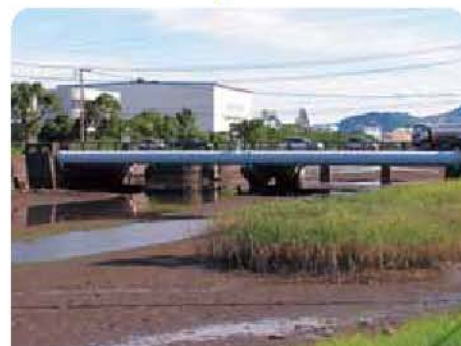
⑥配水管 ここまできたら、工場まであとわずかだよ。工場ではどんな品物ができるか楽しみだね。
