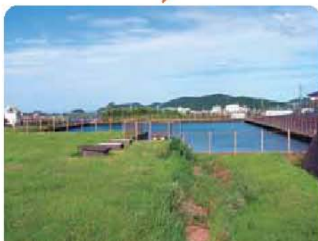
⑤配水池 ここで、いったん水をためて工場に送るんだ。
