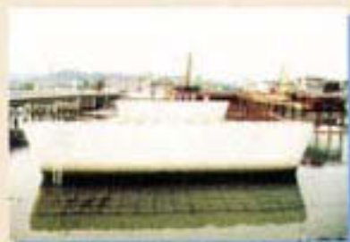
橋台、橋脚の完成
