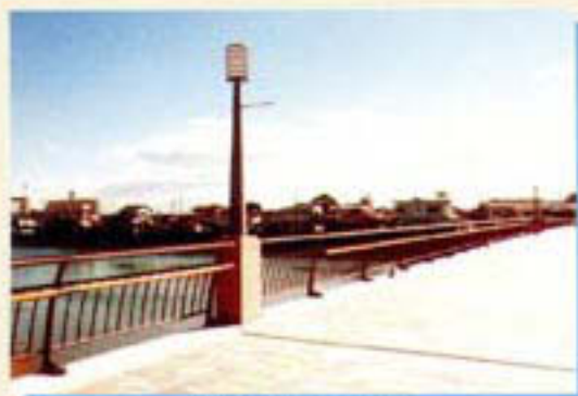
高欄、歩道、照明
