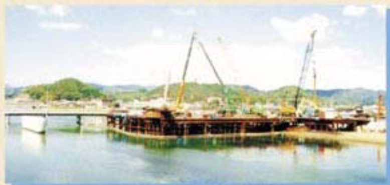
仮栈橋での橋台・橋脚の施工
