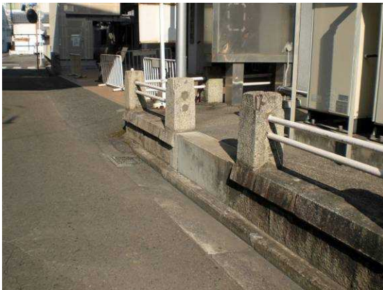
素材や形状が一致していないため、違和感が生じている例
