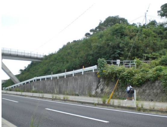
隣接する擁壁の勾配が異なっており不自然な印象となっている例
