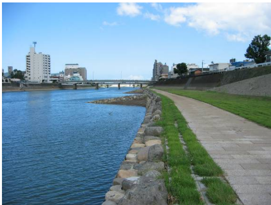
良好な景観の形成に役立っている水制工の例 (延岡市)
