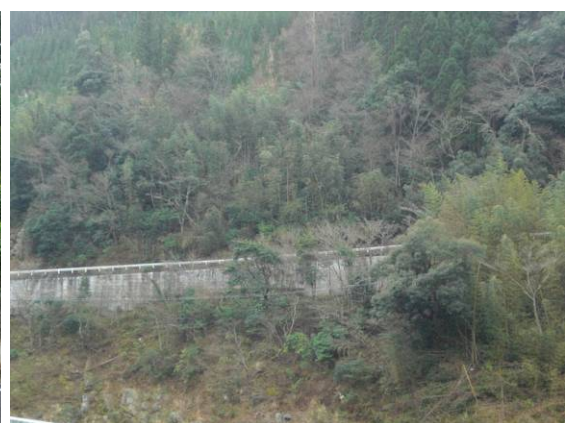
法面の緑化により、その奥の擁壁を見えにくいように配慮した例（諸塚村）
