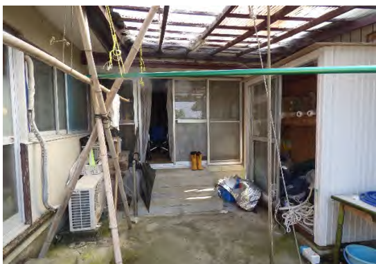
物件南側から物件を撮影③
