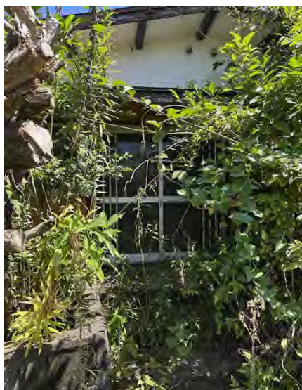
物件南側から物件を撮影③
