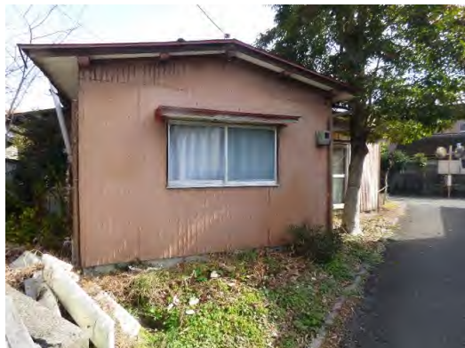
物件南西側から物件を撮影
