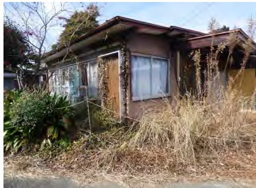
物件北東側から物件を撮影
