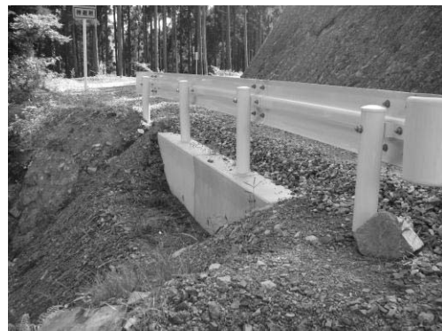
路側構造物施工状況（L型擁壁）
