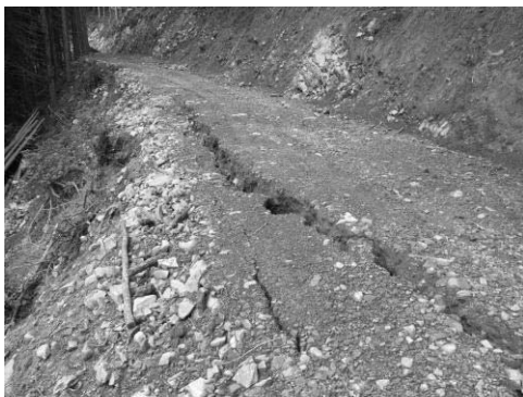
路体盛土（巻出し）陥没状況
