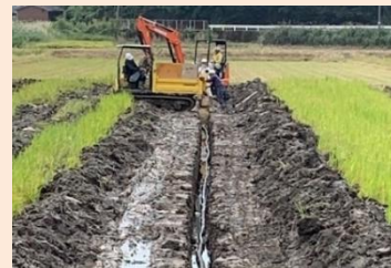
水田の暗渠排水整備
