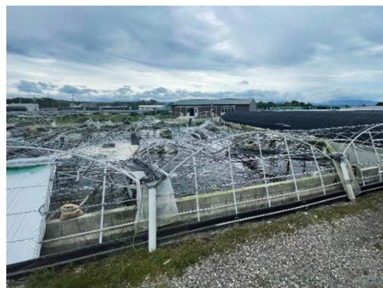
< 突風による陸上養殖施設の倒壊 >
