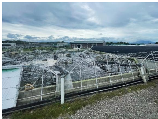
< 突風による陸上養殖施設の倒壊 >
