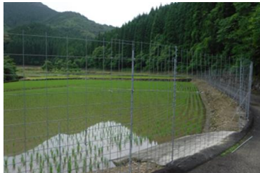
侵入防止柵の整備
