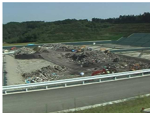
写真-2 処分場内を仮置場として用いる様子
