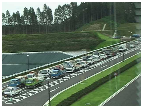
写真-1 場内への搬入状況
