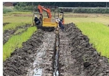
図10 水田の暗渠排水整備
