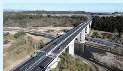
4車線化が進む東九州自動車道(写真は「宮崎PA～清武IC」間)
