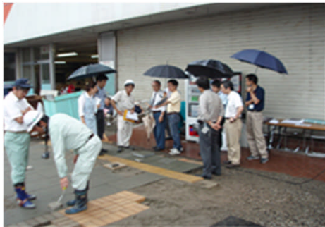
歩道舗装の試験施工
