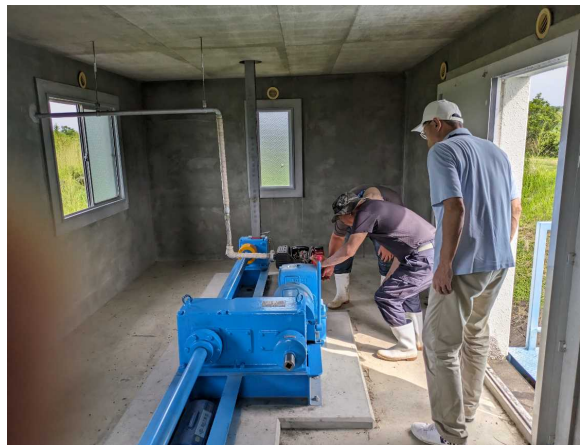
出水期前の水門点検（古川樋門）
