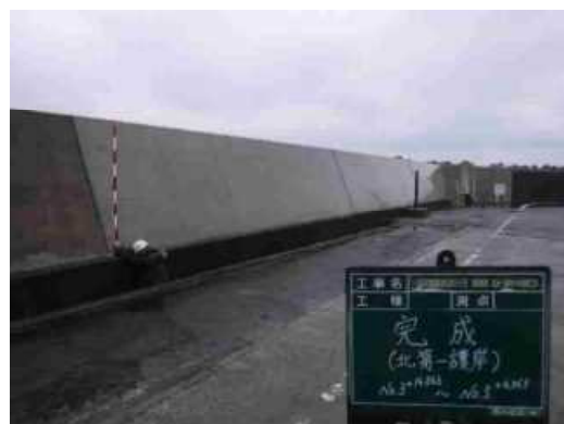
北第一護岸(完成)
