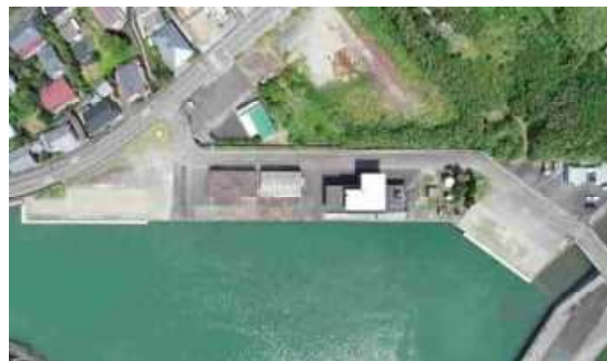
-2m物揚場(完成)
