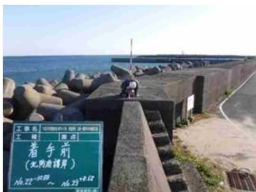
北防波護岸(着手前)
