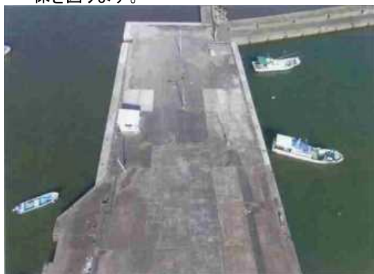
第2物揚場(着手前)
