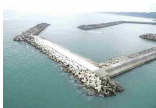
北沖防波堤(完成)
