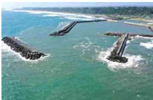
北沖防波堤(着手前)
