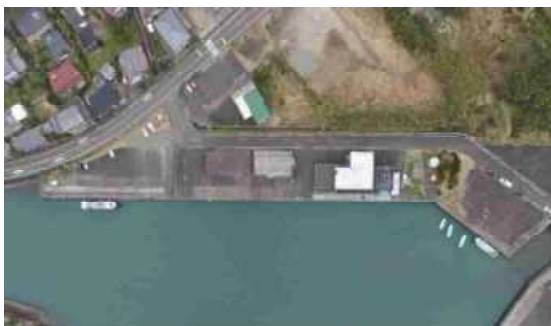
-2m物揚場(着手前)
