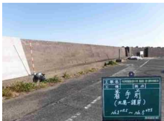
北第一護岸(着手前)
