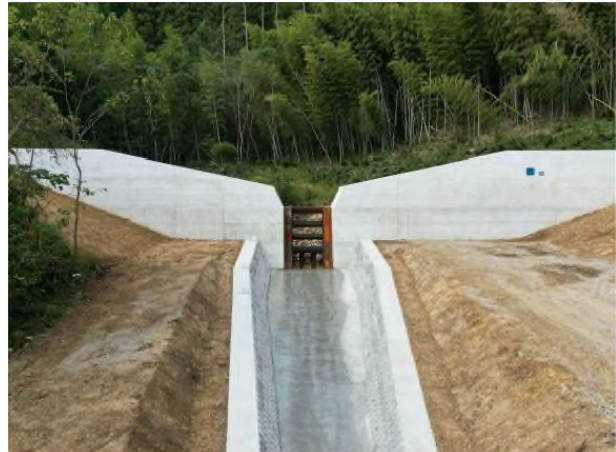
砂防事業 谷川南川（川南町）
