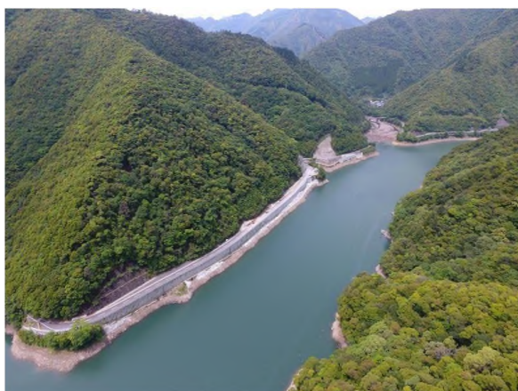
(東郷西都線 松尾工区 施工中)
