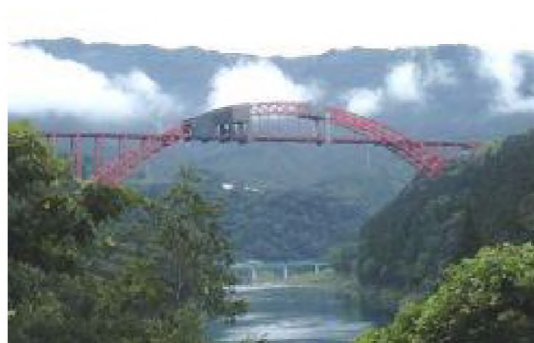
干支大橋（上流側から撮影）
