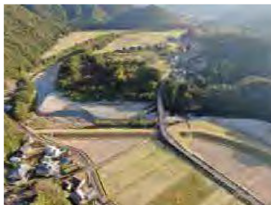
整備状況（妙工区・桑平橋工区）
