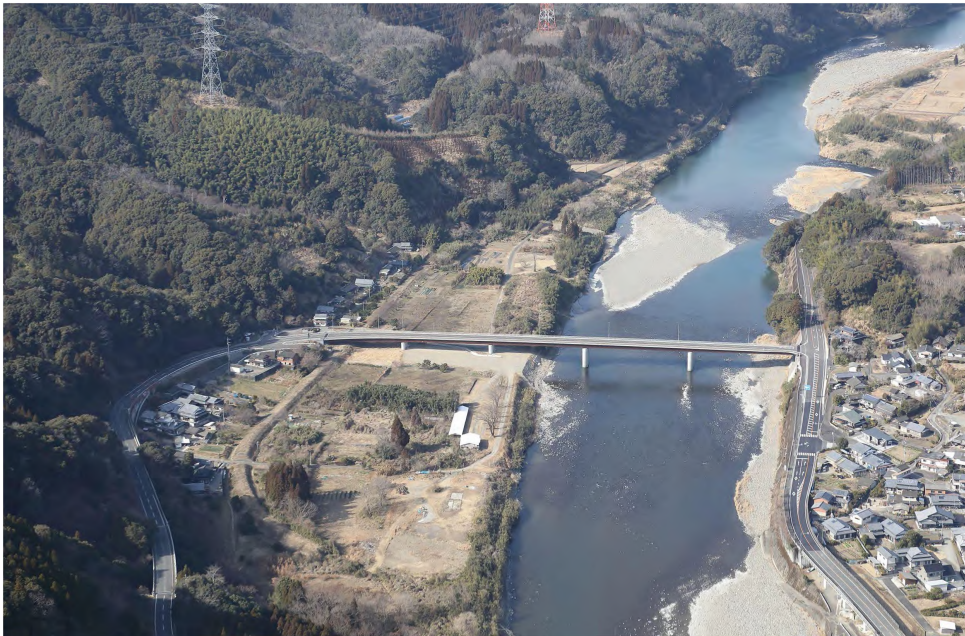
国道 2 1 8 号 川水流橋
