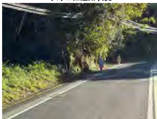
小野工区道路状況
