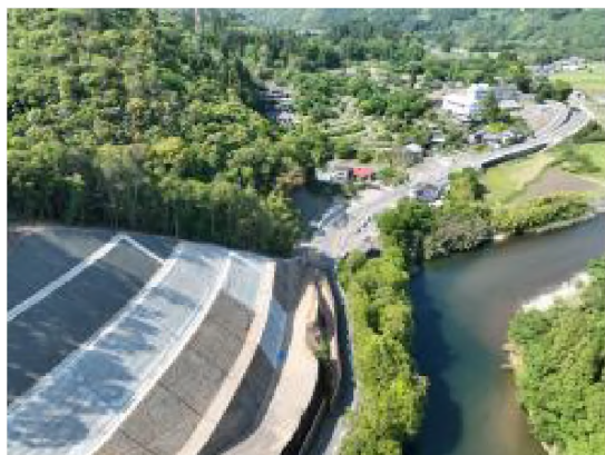
道路状況（黒岩工区）
