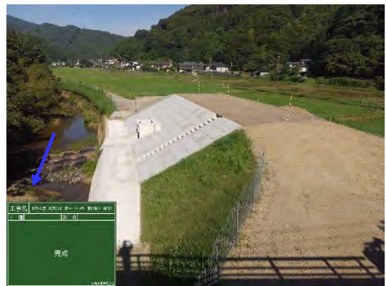
鹿狩瀬地区 (R6.5 状況)
