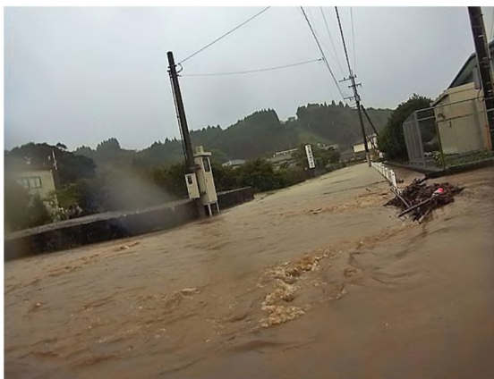
平成26年の浸水状況
