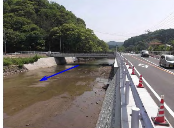
飛川橋(橋梁完成)
