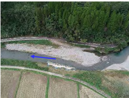
掘削・状況(曾木川：北方町曾木地区)
