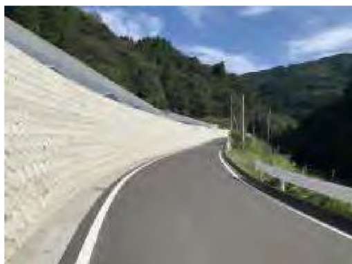
板上曾木線整備状況（三槌工区）
