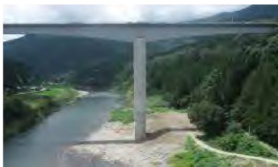
P1 橋脚補強工事
