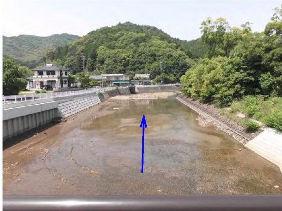
飛川橋下流(護岸完成)
