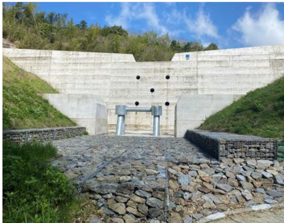
高野谷川砂防堰堤（R5 完成）
