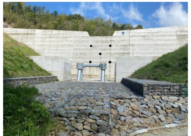
高野谷川 砂防堰堤整備
