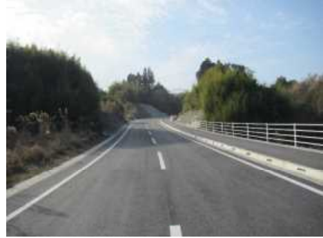
令和4年度改良区間
