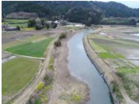
掘削・堤防嵩上げ完了
