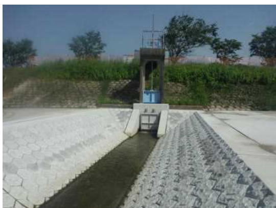
福島川寺園樋門
