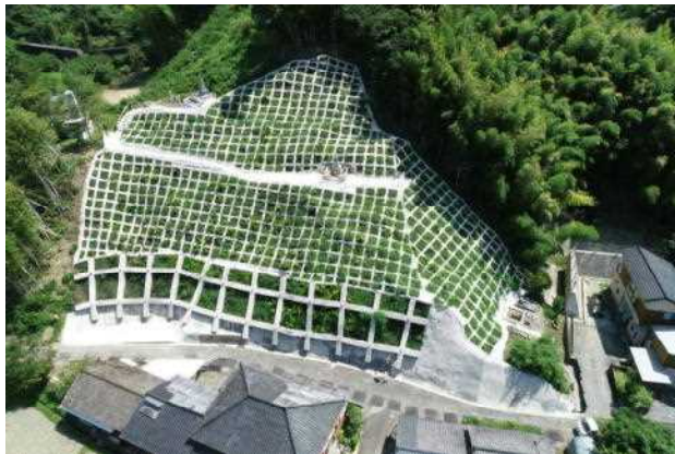
東地区対策完了後
