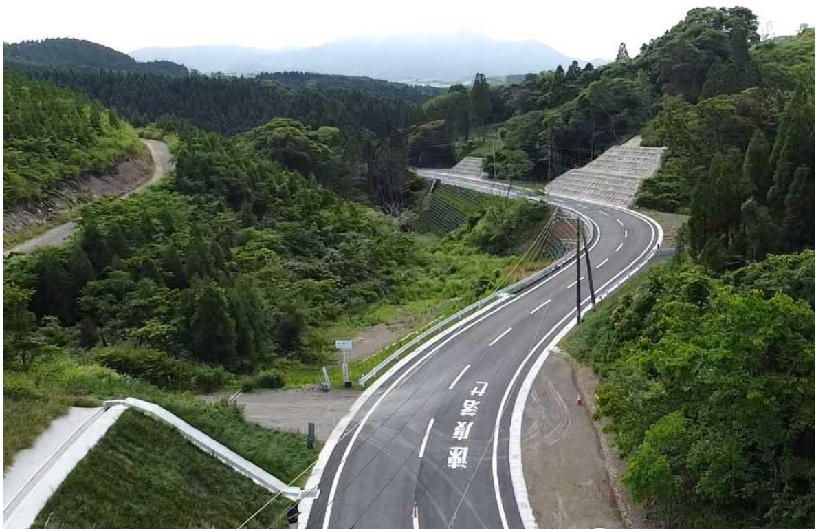
令和4年度完成 一般県道 北方南郷線 秋山工区 道路改良工事
