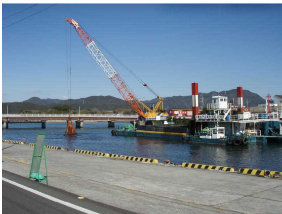
福島港（泊地浚渫状況）
