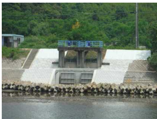
福島川7号樋門
