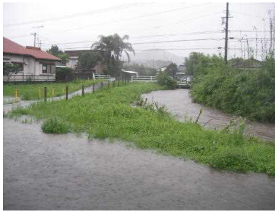
天神川の出水状況；平橋下流（H24.6梅雨前線豪雨）
