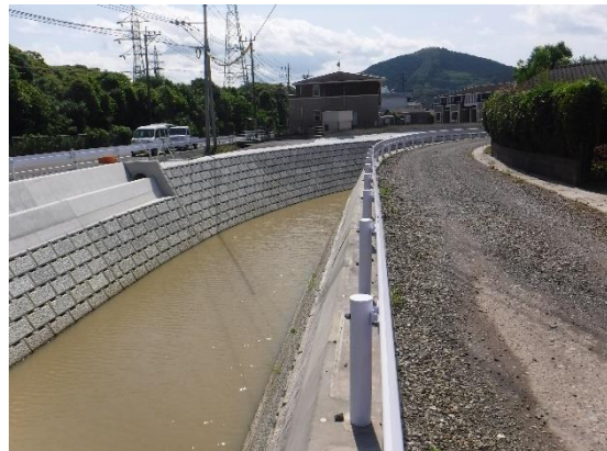
戸高川 河川改修（S58～）
