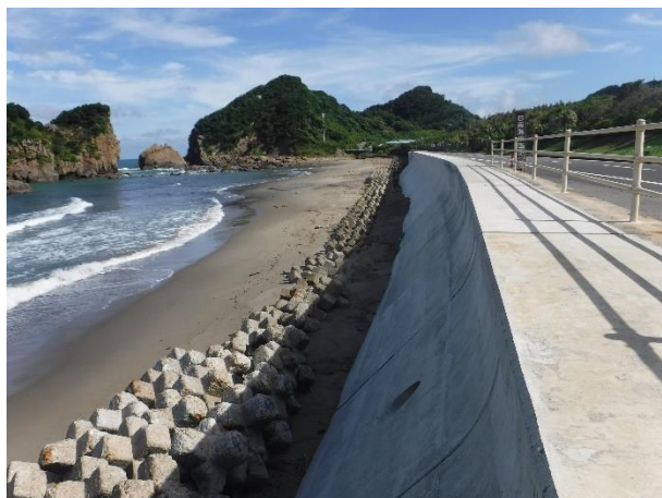
古奥海岸（護岸工）R5完
