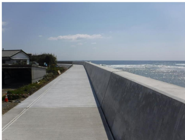
平山海岸（護岸工）H28 完
