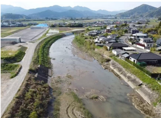
益安川 河川改修（H14～）
