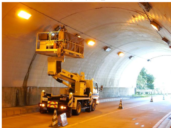
トンネル点検（国道 222 号）
