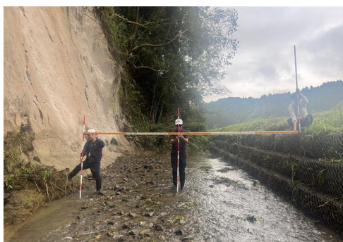
RO6災 屋根田川 河川埋塞 工事完了後（土砂除去）
