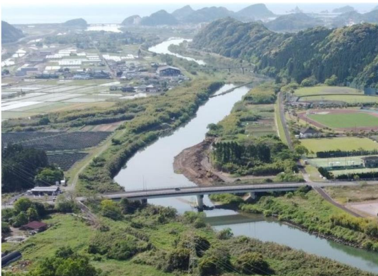
広渡川 河道拡幅（H4～）
