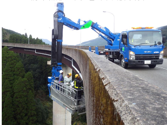
橋梁点検（県道都城北郷線）
