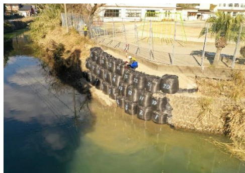
RO6災 宮浦川 護岸被災 応急復旧完了（土のう設置）
