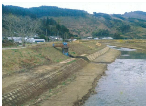
河道掘削及び樹木除去（R2～）
