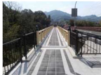
県道下野鹿狩戸線 歩道整備
