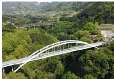
国道218号（雲海橋）
