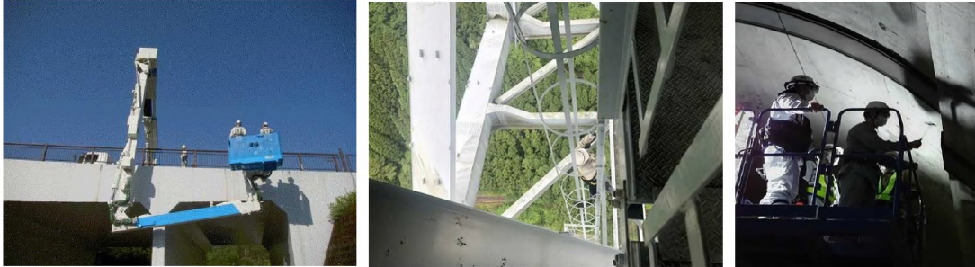
橋梁やトンネル等の定期点検の様子
