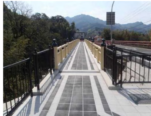
県道下野鹿狩戸線 歩道整備
