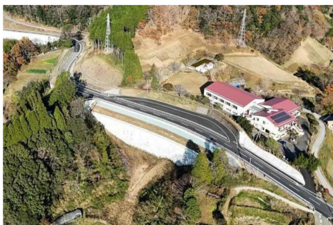
道路改良事業（竹田五ヶ瀬線土工区）
