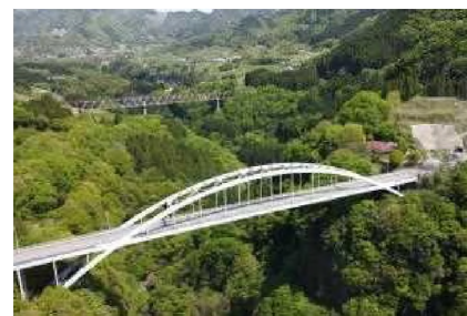
国道218号（雲海橋）
