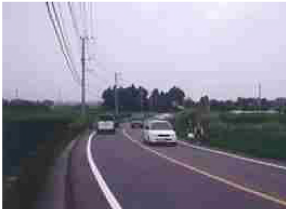
県道宮崎田野線 法光坊工区
