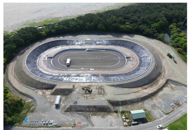
自転車競技場整備中(令和7年度完成予定)
