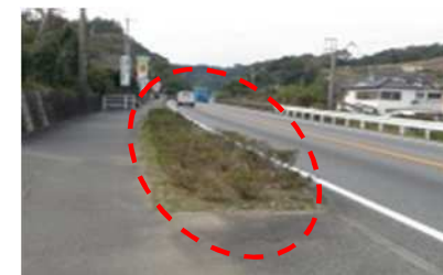
植栽帯を撤去し歩道にする
