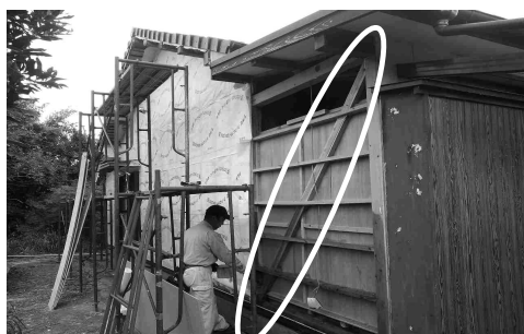
耐震改修工事（筋交い取付）
