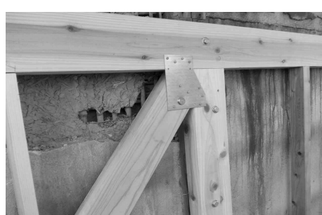
耐震改修工事（金物補強）
