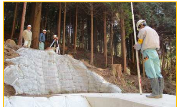
治山工事の完成検査
