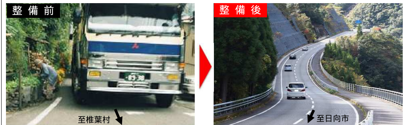
写真5 整備前と整備後の道路状況 (幅員狭小)
