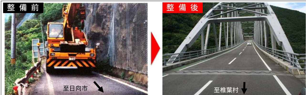
写真4 整備前と整備後の道路状況 (道路線形)
