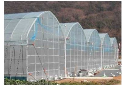
かさ上げにより軒高を高くしたハウス
