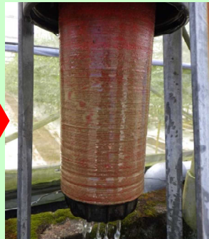
中のフィルターにはゴミが付着
