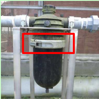
ストレーナーの外側の止め具を外して開ける
