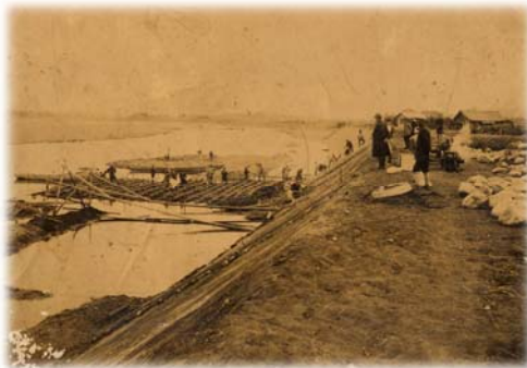
写真：粗朶沈床作成風景
