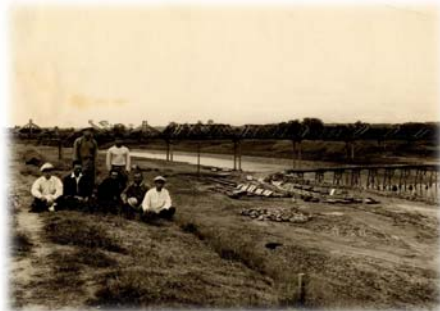
工事現場の風景
