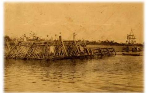
水制工組み立て風景
