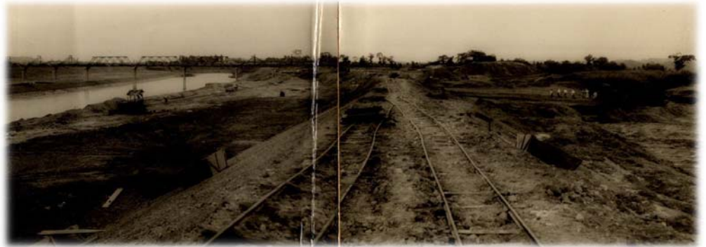
堤防上に設置されたトロッコ線路 (鳥子の捷水路掘削工事の風景)
