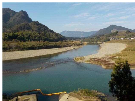
工業用取水口付近（11k320）：令和2年11月撮影
