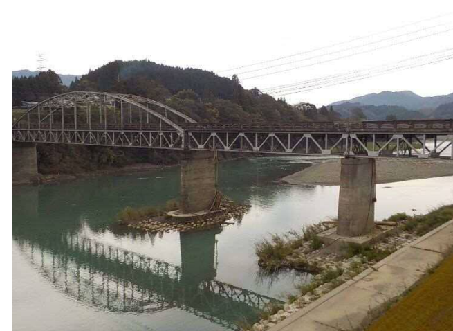
八重原橋 : 令和4年11月17日撮影
