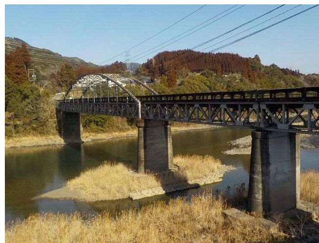
八重原橋 : 令和4年2月1日撮影
