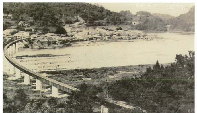
完成した鉄橋
