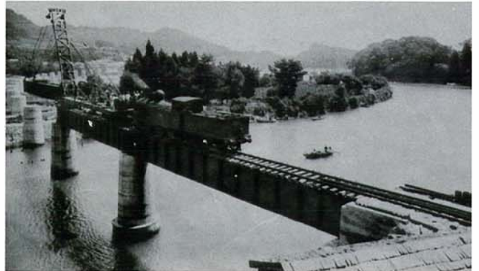
工事中の鉄橋
