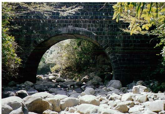
坪谷本村橋（東郷町・坪谷川）
